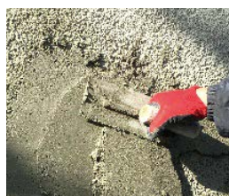
左官工法による施工状況
