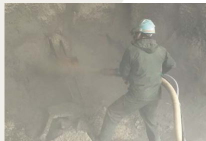
粉塵対策を実施していない乾式吹付工法
